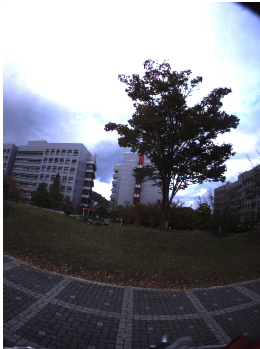
図 36 類似構造を持つ建物 (データベース構築時撮影画像)
